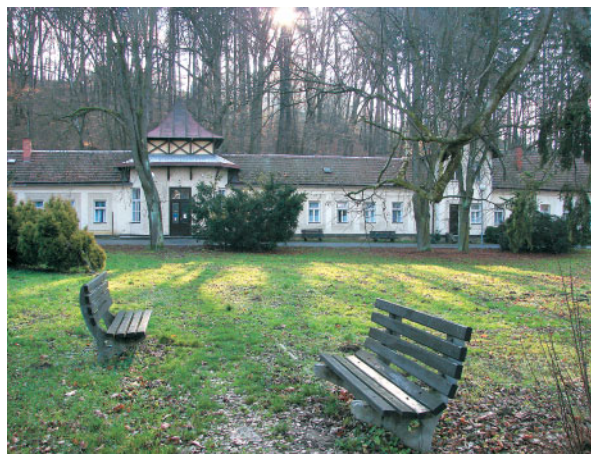
Budova původních lázní
